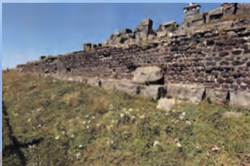
■ Le mur sud avant restauration ©Beaulaton
